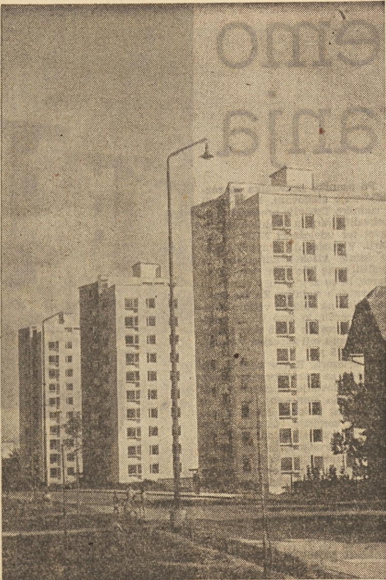
Letos bodo Jeseničani dobili kakih 260 novih stanovanj, med njimi tudi te tri stolpnice, kjer pravkar končujejo zadnja obrtniška dela
