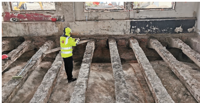
Slika 7. Obstoječi nosilni elementi medetažne konstrukcije (foto: arhiv Elea iC, d. o. o.).
