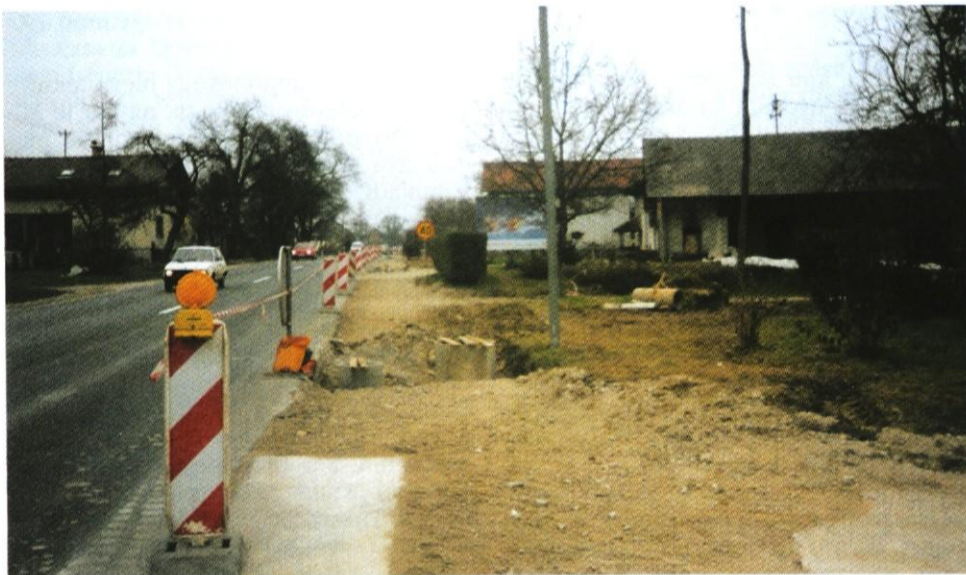
Na Prevojah se je pričelo z gradnjo pločnika vendar brez kolesarske steze
