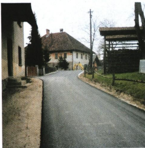
Položili so asfalt pri Španu vendar prekratko še posebej pa moti izvoz na regionalno cesto 610 saj je višina v križišču izdelana prenizko - stara rana
