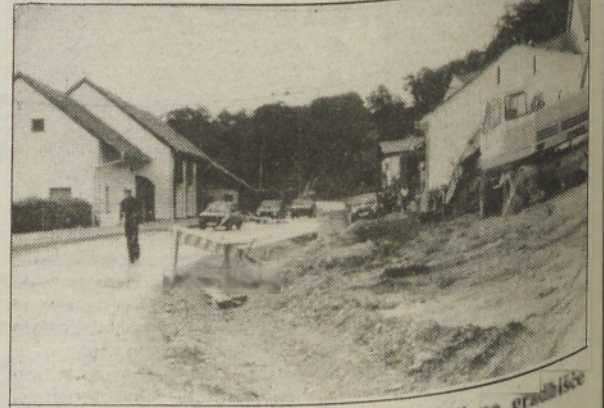
Delavci in stroji Pomgrada se bodo vrnili na gradbišče v Stročji vasi. (Fotografija: J. G.)
