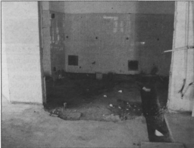
Priprava na sanacijo sanitarij
