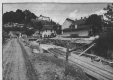
Gradbena dela v izvajanju na Drožanjskem potoku...
