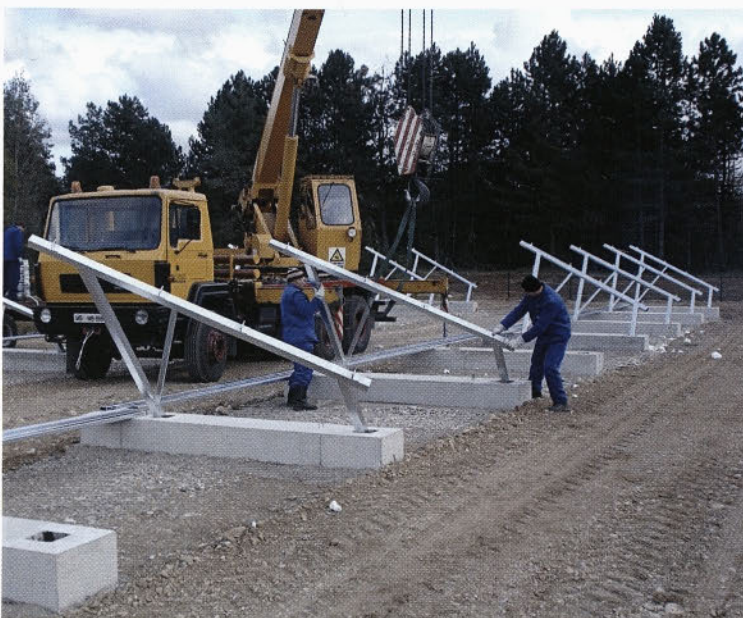
Izgradnja temeljev za sončne celice
