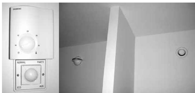
Slika 2: Napravi za upravljanje PSH in vhodni in izhodni zracni ventil PSH. Figure 2: PH operating instruments and PH air outlet/inlet valves.
