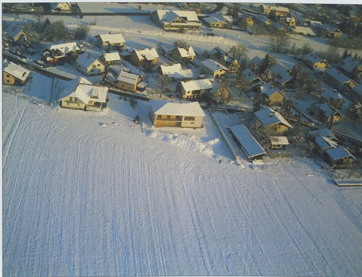
Nova poslovno-stanovanjska stavba na sredini posnetka, napravljena s pomočjo brezžičnega prenosa
