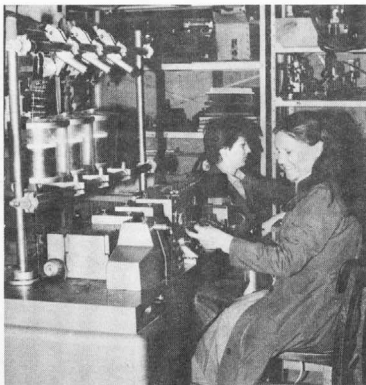
Navijalni stroj za rotorje elektromotorja.
