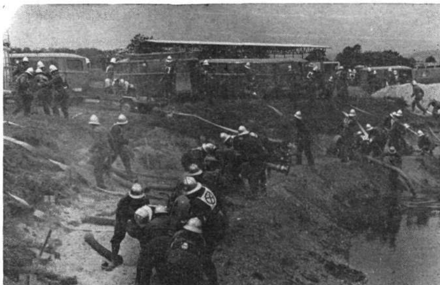
Motorne črpalke so sposobne opraviti s požarom le, če je blizu dovolj vode
