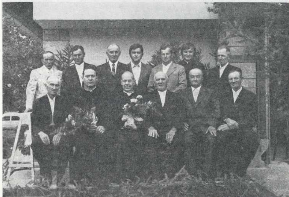
Gradbeni odbor pred novo kapelo v Trnju
