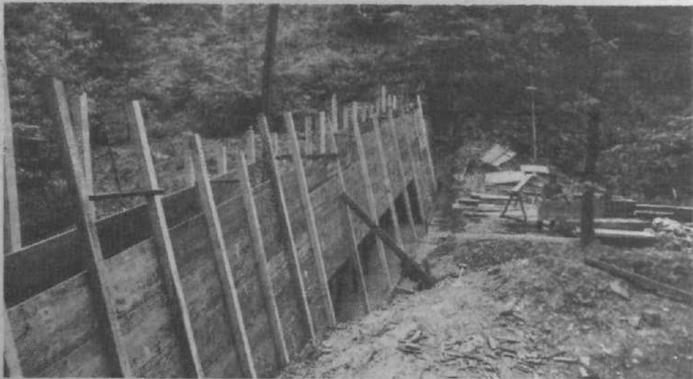
Največ dela je bilo z zadrževalno zaporo na Klemenčevem grabnu, ki bo zadrževala prodnati material. Zapore je široka 45 m, na najvišjem mestu pa meri 3 metre. Zaradi podražitve del bodo Zaborški hudourniki uredili šele prihodnje leto, Klemenčev graben pa bodo takrat uredili do izliva v Lisco.
