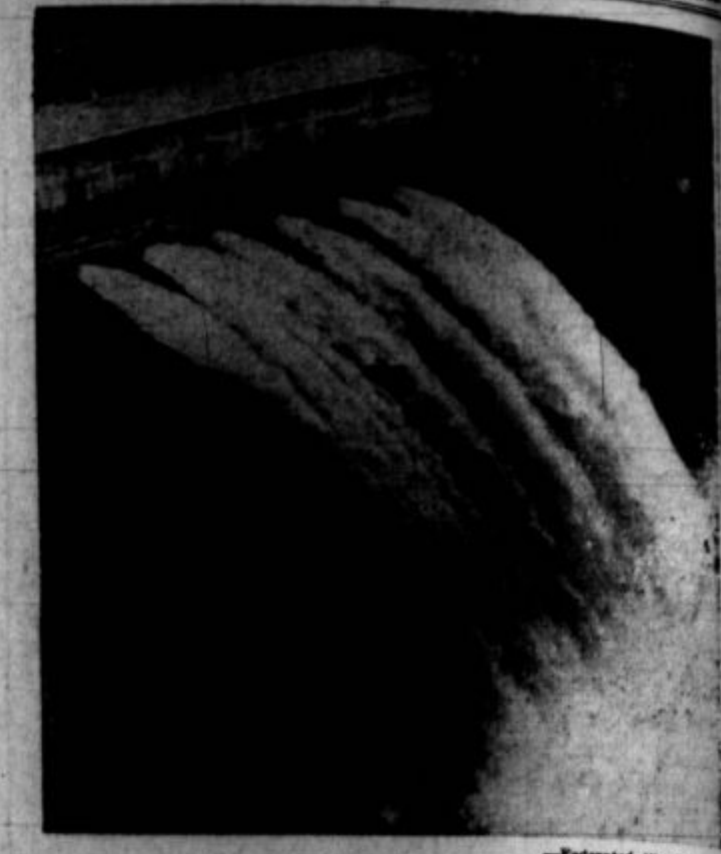
Slika kaže odprtine jezca Boulder, skozi katere gre 30,000 ga nov vode v sekundi.
