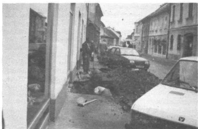
V starem mestnem jedru Krškega potekajo dela druge faze izgradnje telefonskega omrežja (gradnja posameznih odcepov). Prejšnji teden so delavci položili TT kabel na Cesti krških žrtev, kar bo omogočilo nove telefonske priključke v tem delu mesta. (B.B.)
