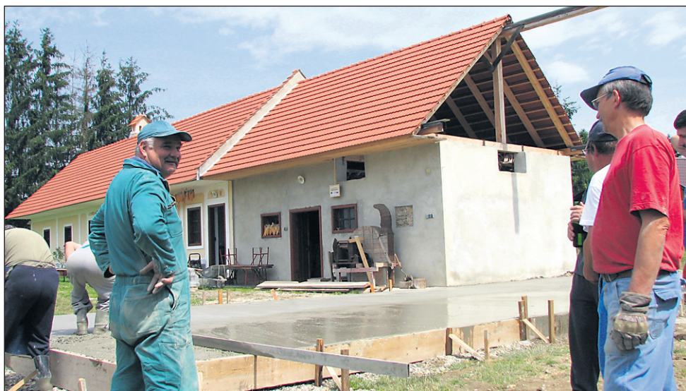
Potem ko so prostovoljci zabetonirali temeljno ploščo na Djočanovi kmetiji, je bilo slišati zelo zanimivo idejo, kaj bi lahko nastalo na tej lokaciji namesto predvidenega skedenja in kolarnice ...
