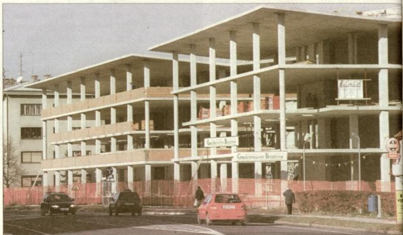
Ob Ljubljanski cesti v Celju gradimo stanovanjsko poslovna bloka s stanovanji z višjim standardom.
