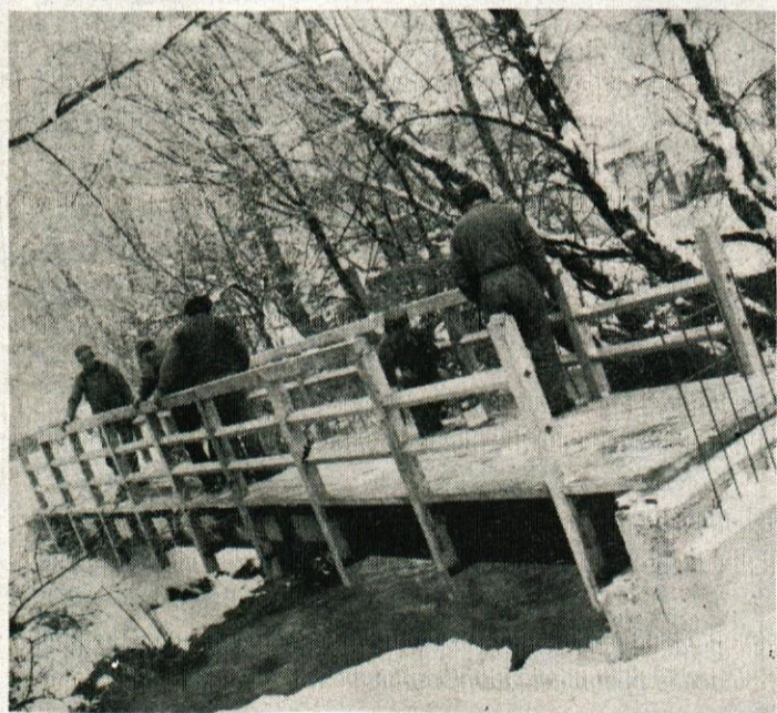
Delavci Komunalnega podjetja na železno konstrukcijo pritrjujejo leseno ograjo in pod.
