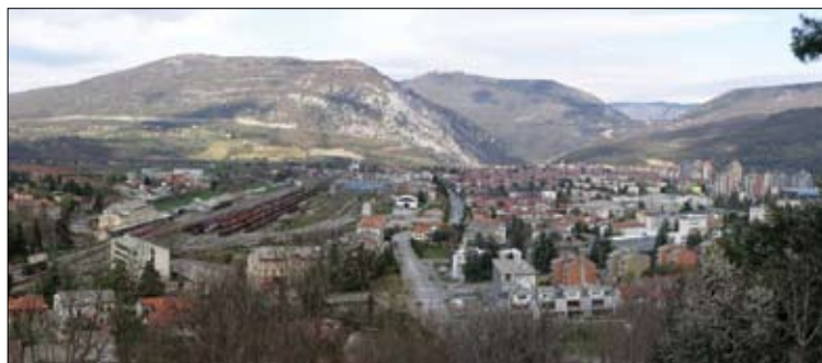
Sedanji pogled na železniško postajo v Novi Gorici
