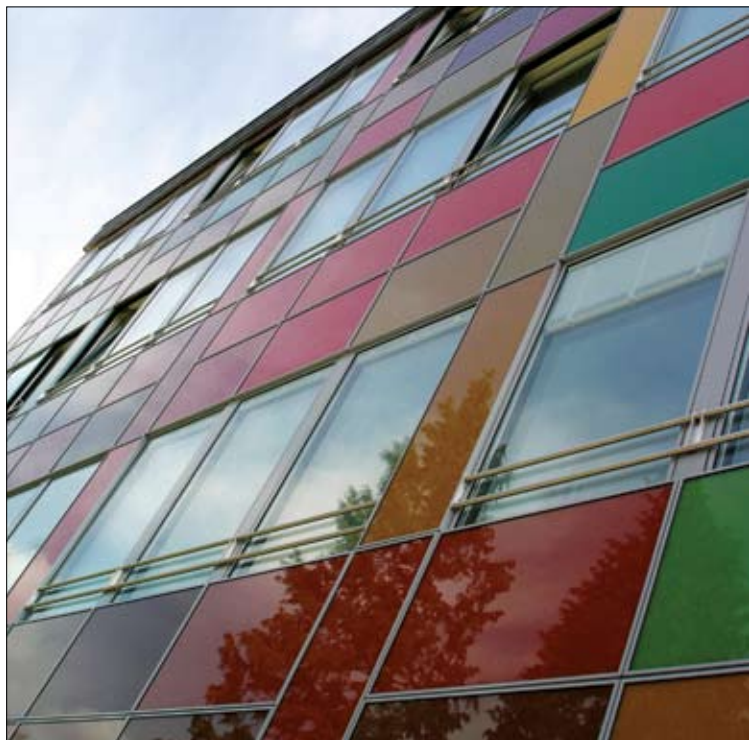
Dom za ostarele, Weiz – toplotno izolativno steklo omogoča nizke energetske potrebe
