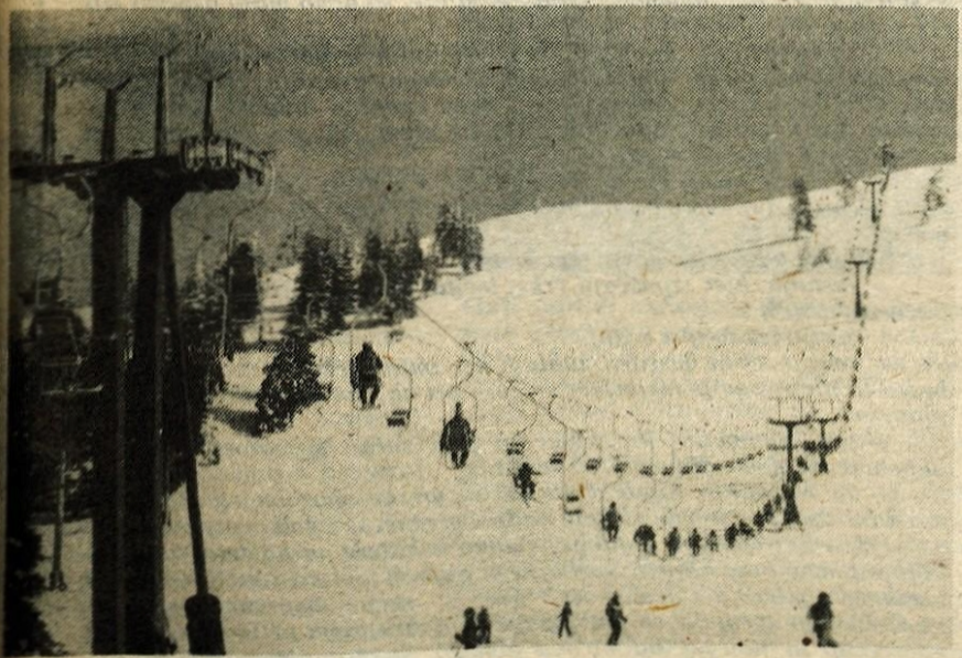
Na zahtevo Zavoda za raziskavo materiala so na Krvavcu morali sanirati trinajst let staro žičnico, ki pelje do Doma. Od prejšnjih 400 oseb na uro prenovljena žičnica sedaj popelje do Doma 900 smučarjev na uro.
