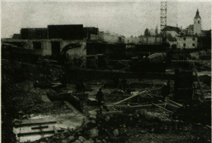
Soseska Mali grad navzlic vsem zapletom vztrajno raste, saj graditelji že postavljajo stene prvega nadstropja.
