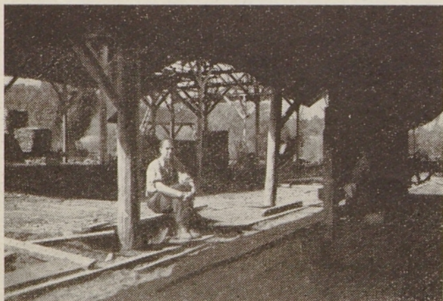
Dano Serko pri postavljanju žage v Salti
