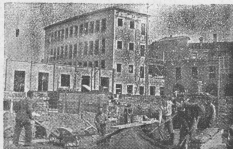
GRADNJA NOVE RIBARNICE V KOPRU
