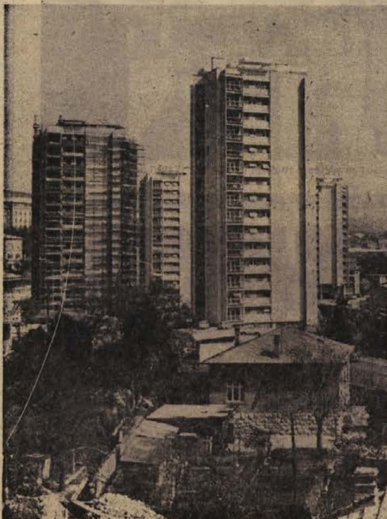
Nove stanovanjske stolpnice na Reki, ki jih je SGP PIONIR gradilo lani in letos
