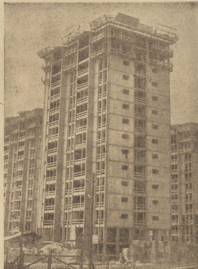
Stolpnice v Savski koloniji. Stena z okni je grajena na montažni — PBM način. Elementi so podolgovati betonski bloki in okenski okvirji
