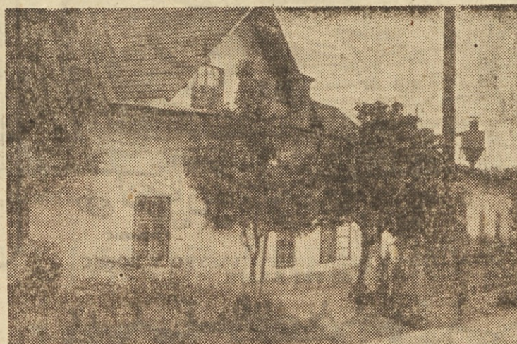
Stavba obrata Gorje podjetja LIP Bled
