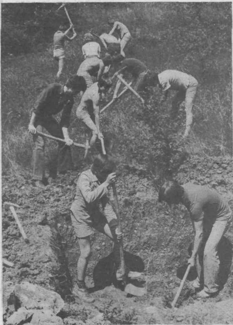
Na trasi bodočega vodovoda
