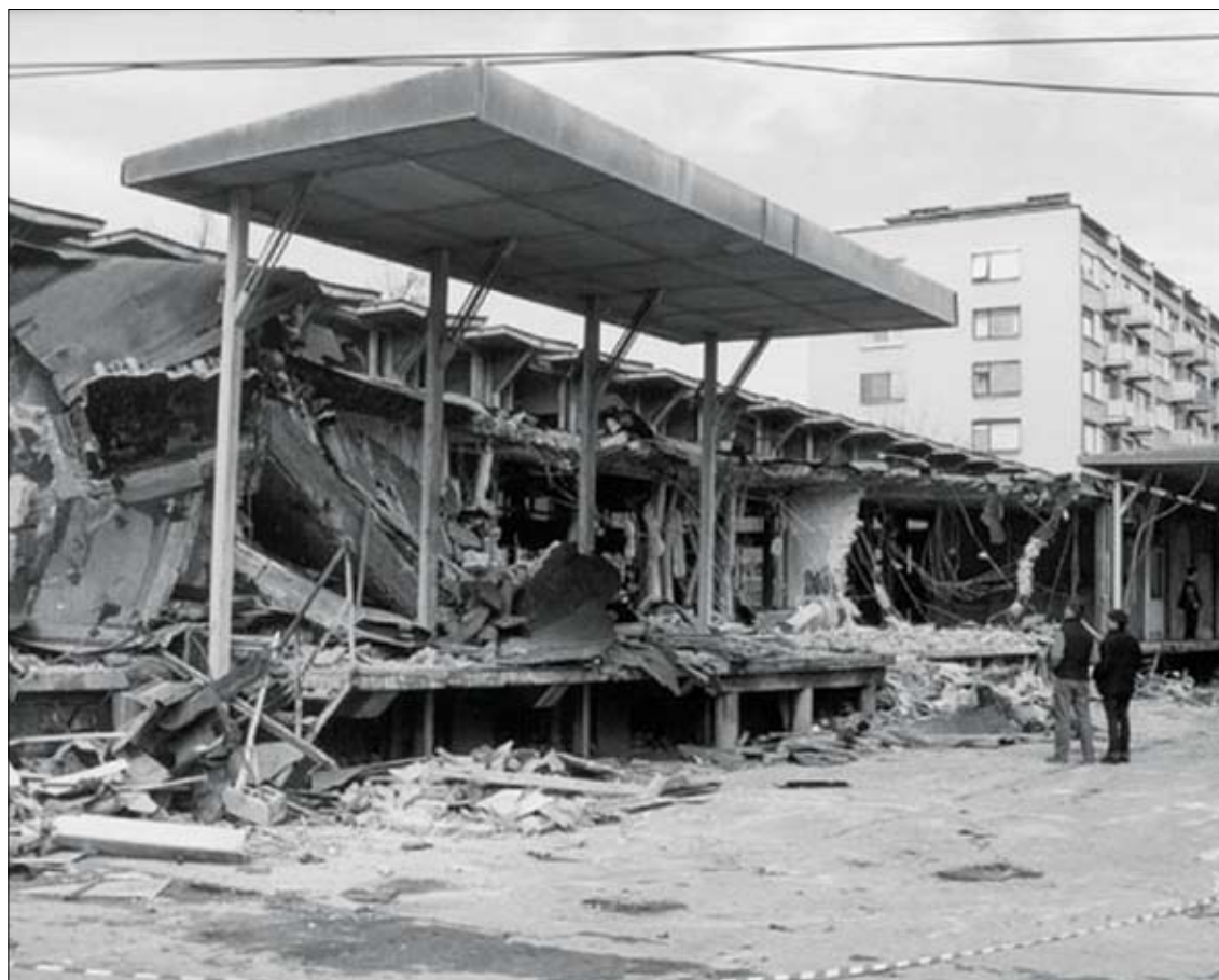
Rušenje Učnih delavnic ZGM Bežigrad v Ljubljani. (Vir: www.evidenca.org )
