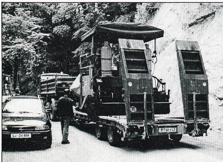
Asfaltiranje cestnih odcefov
