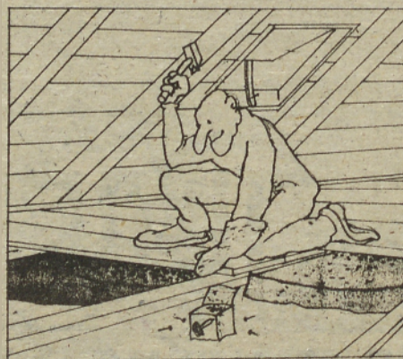
Polaganje toplotne izolacije na pod- strešju NOVOTERM P-16 ali F-16
