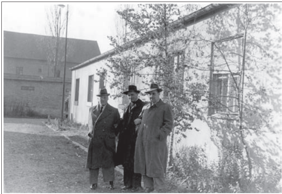
Pirkmajer pred obnovljenimi barakami v Dachauu, 1946. MGML, 510:LJU;0066539 (Foto Blaž Gutman).
