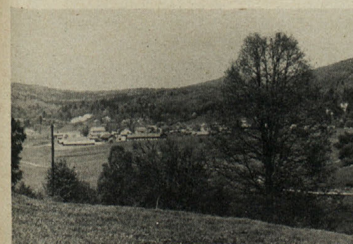
Pri gradnji vodovoda v Koprivniku je bilo potrebno izkopati 1480 m jarka za cevovod ter izkop jarka za zbiralnik in zajetje v dolžini 190 m. Z izgradnjo dveh rezervoarjev pa je tu na zalogi tudi 600 m 3 vode za sušno obdobje.
