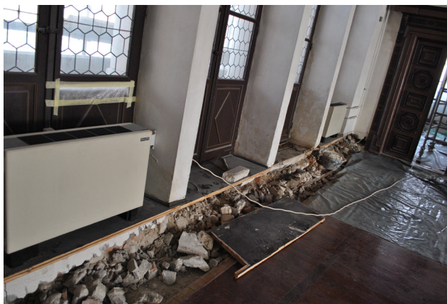
Slika 5: Gradbena dela ob prenovi muzejske palače Belgramoni-Tacco (foto: Maša Saccara, 2015).
