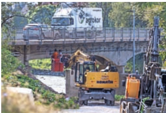
Zaključuje se obnova v poplavah uničenega primarnega vodovoda na mostu čez reko Soro na državni cesti v Medvodah. Vrednost del je slabih 140 tisoč evrov. / Foto: Peter Košenina
