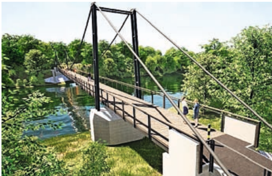
Vizualizacija brvi med Vikrčami in Mednom. Delati naj bi začeli še ta mesec. Gradnja bo stala 1,4 milijona evrov. Brv bo precej širša (širina vozišča 3,5 metra), brez strehe, konstrukcija bo jeklena. / Foto: arhiv Občine Medvode
