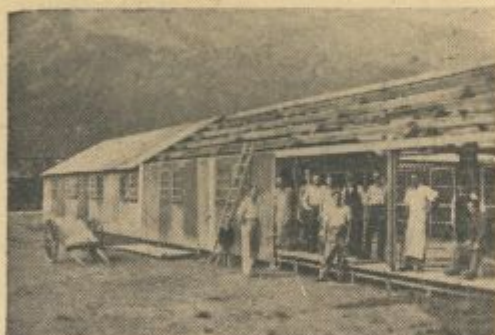
Gradba "gimnazije" v Spittalu.
