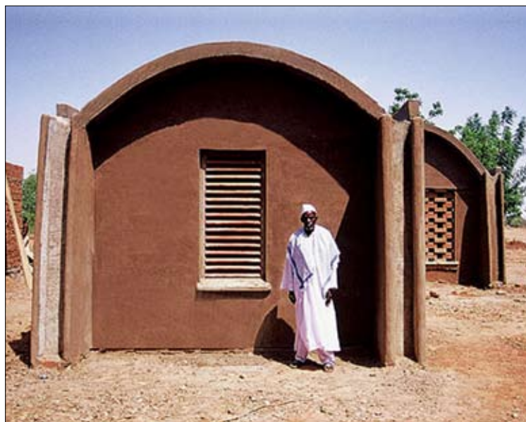
Domovi za učitelje šole, Gando, Burkina Faso - poskus oživljanja tradicionalnega načina gradnje s prstjo in glino
