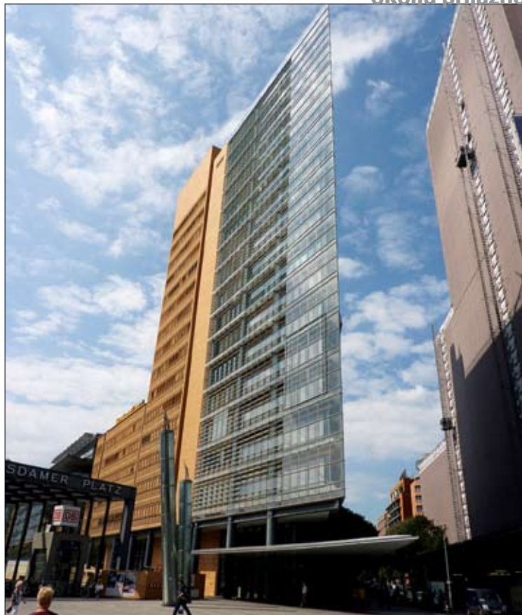
Poslovna stavba Debris v Berlinu, Renzo Piano
