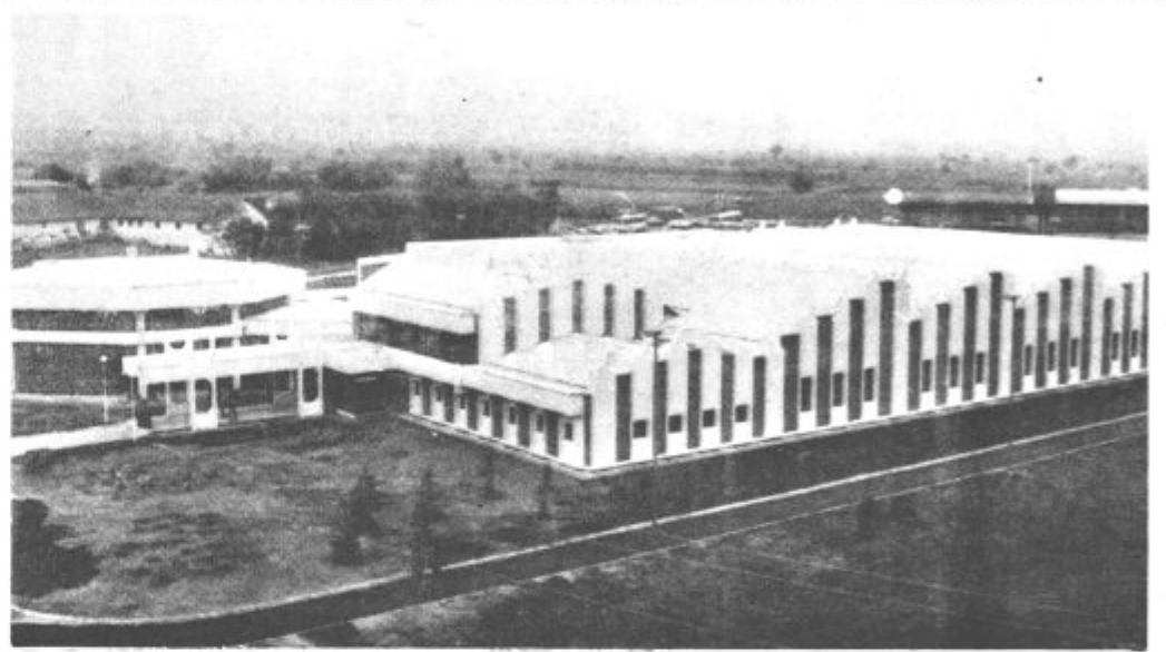
1. V Preševu smo zgradili sodobno industrijsko halo
