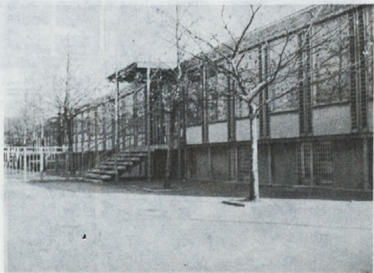
Naslednje leto je na vrsti tudi posodobitev stavbe.
