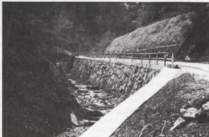
Rekonstrukcija ceste Leše - sanacija opornih zidov pri opuščnem Franciskovem rovu
