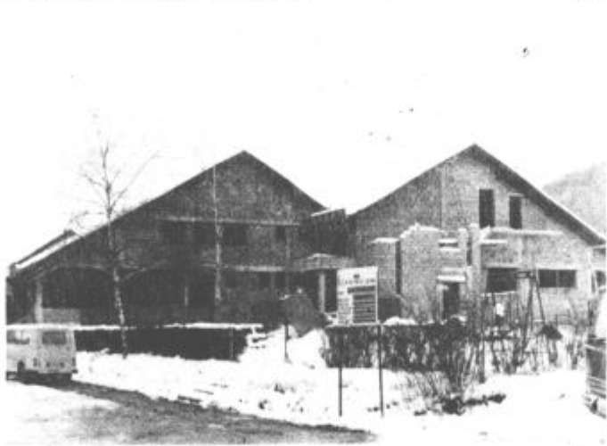
Gasilski dom in dom DPO v Pesju je že pod streho.
