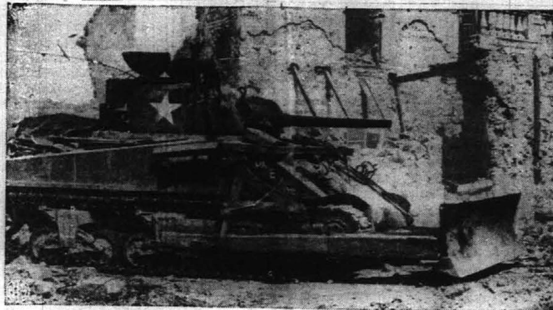
Na M-4 tanke v Italiji so zdaj pritrčili spredaj posebno kovinsko odpralo, tako da ti ogromni vozovi niso le borbene enice, temveč čistijo podrtina, kopljejo jarke in pogasijo ognje. Tukaj je še en takšen tank, ki lahko gre kamor koli. Uporabljajo jih daleč naprej ob bojnih frontah.
