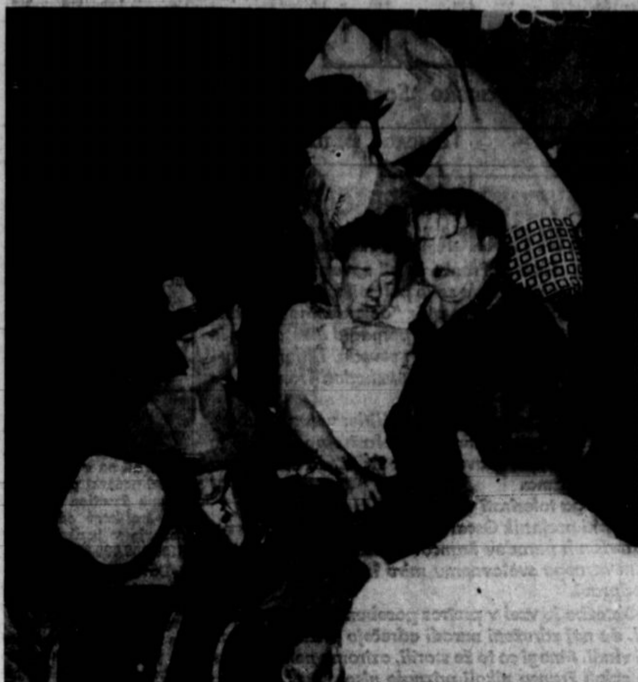
HOTELI V AMERIKI so moderni, a je med njimi veliko takih, ki so "fire trap". Namreč pasti, da se človek iz njih v slučaju požara težko reši. Ali pa sploh ne. Dosedaj je bilo meseca junija že kakih pet hotelov v požaru, in pa nekaj stanovanjskih hiš, v katerih je izgubilo življenje nad sto ljudi. Gorje je slika iz nedavnega požara v hotelu LaSalle v Chicagu. V njemu je izgubilo življenje 60 ljudi.
