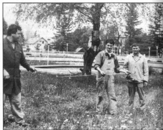
Delavci Podjetja za urejanje prostora urejajo okolico bazena v Šoštanju. Med drugim bodo ob delu kopališkega kompleksa postavili lično ograjo.
