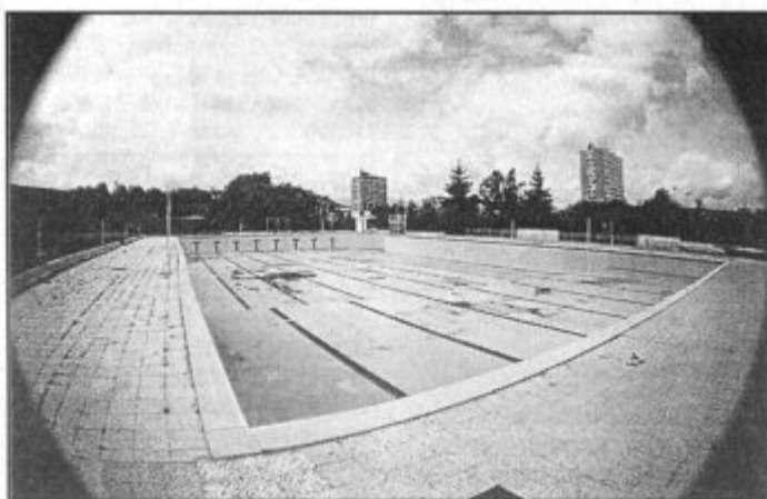
Utrinek z bazena v Velenju, preden so začeli z obnovitvenimi deli.
