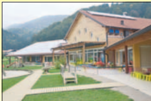
Ekološki objekt – Vrtec Marjetica z nameščeno sončno elektrarno in sončnimi kolektorji
