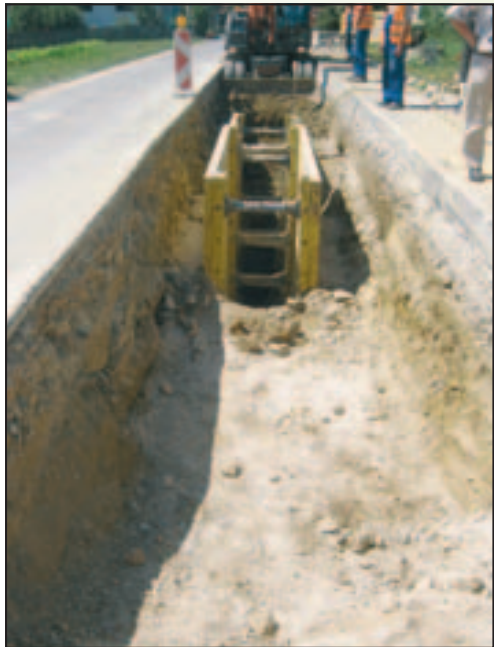
Sočasno z javno kanalizacijo so v gradnji odcepi za hišne kanalizacijske priključke.
