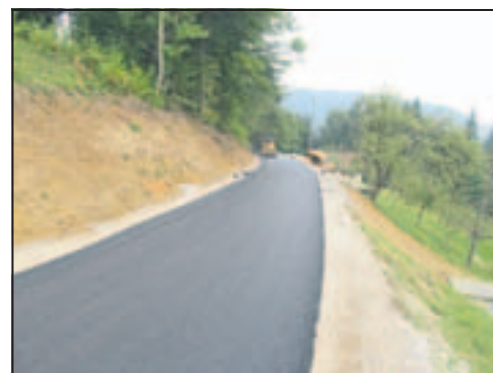
Obnovljena in asfaltirana cesta Rovt-Alič-Buh
