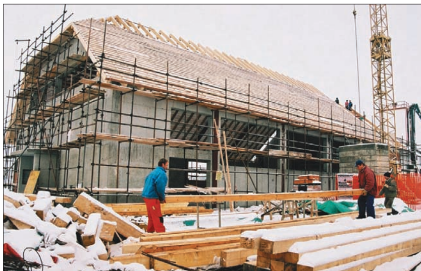
Nova dvorana ob gasilskem domu v Bukovcih je že pod streho
