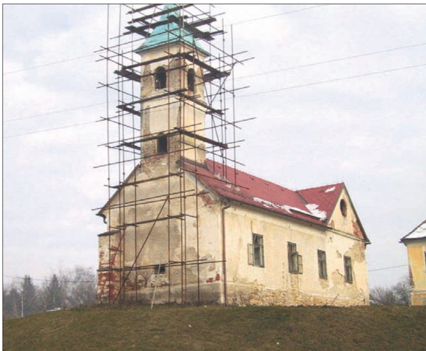
Na cerkvi sv. Katarine v Cirkulanah je bilo potrebno pred nadaljnjimi vzdrževalnimi deli obnoviti ostrežje
