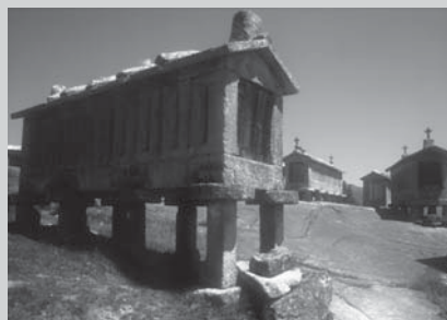
□ Slika 4. Koruznjak: slovenski koruznjak je seveda lesen; prvotno in najstarejši so v prepletu in s slamnato streho, kasnejši, masivnejši pa so povsem podobni tistim v kontinentalnem delu Galicije (španija).
