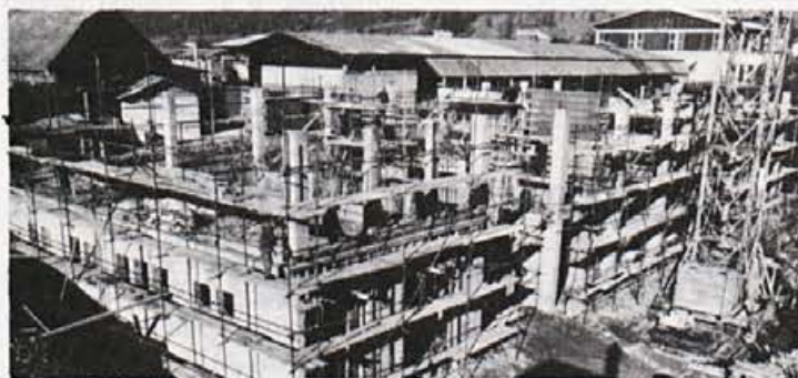
Novo skladišče vnetljivih tekočin in materialov v gradnji
