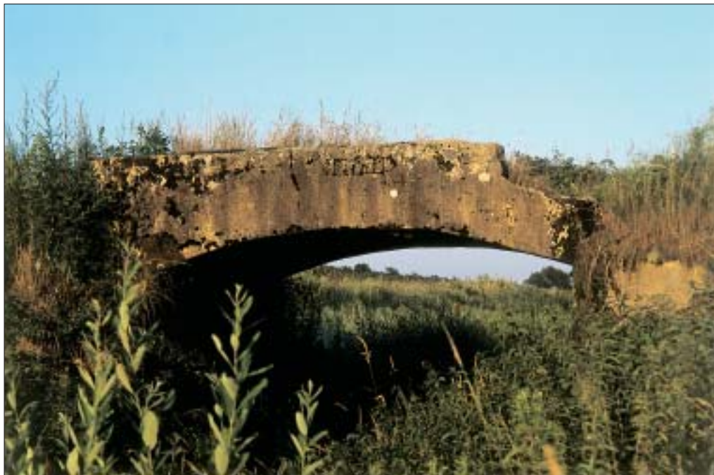
Slika 116: Posamezne poljske skupine povezujejo manjši zidani mostovi.
