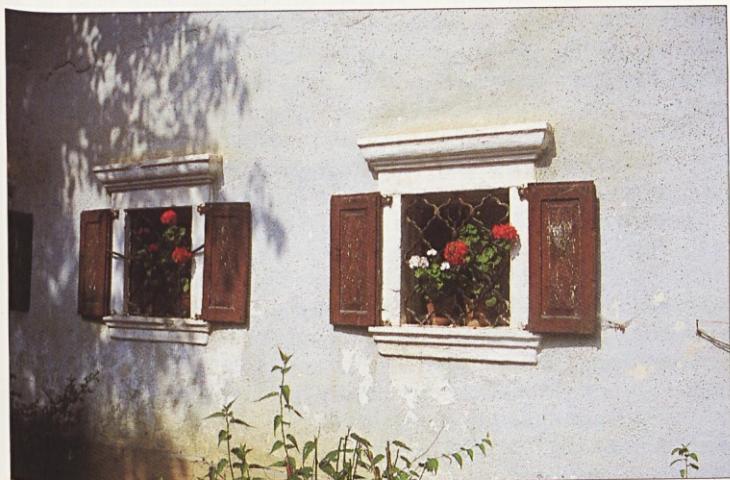
Matijeva biša pri Sv. Dubu, baročna okna (foto: Peter Pokorn)
