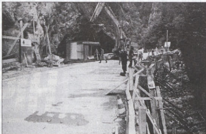
Dela na cesti Mislinja - Velenje
