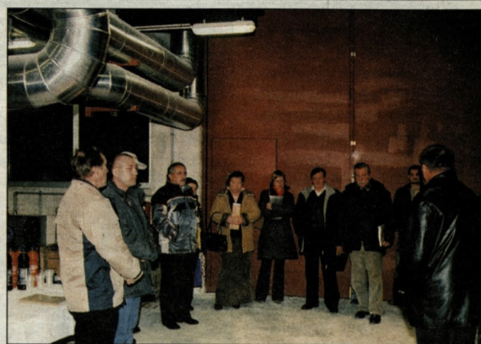
Svetniki v novi kotlovnici na biomaso
