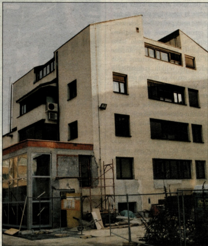
Gradbena dela so že končana.
