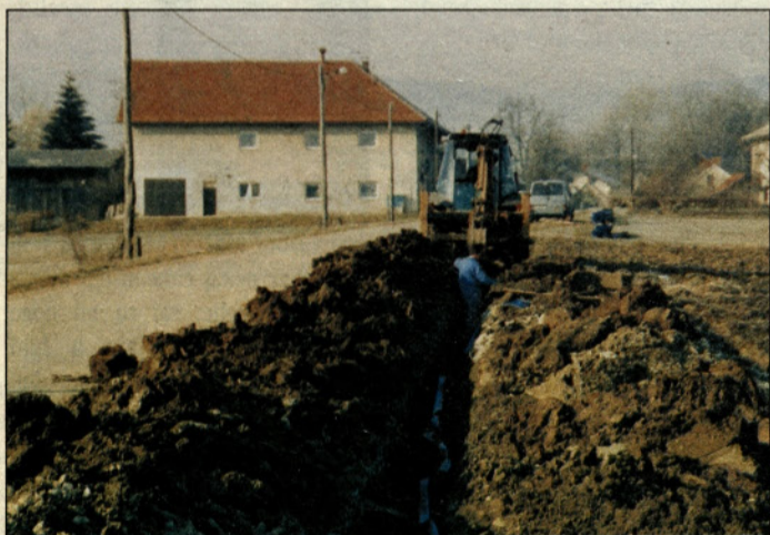
Polaganje cevi glavnega vodovoda v Kaplji vasi
