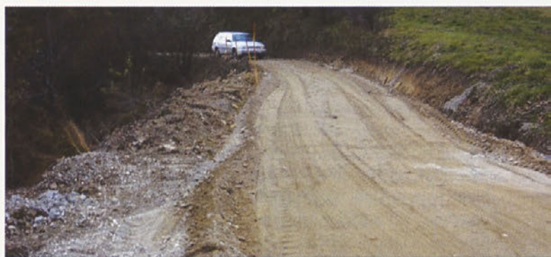
Modernizacija ceste v Rodnem Vrhju
